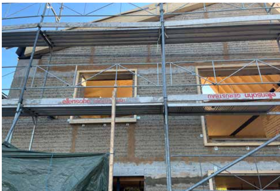
Byggeri opført i vægelementer af stampet lerjord. Byggeriet er udført af den østrigske virksomhed Lehm Ton Erde. Foto: Nicolai Gregersen
