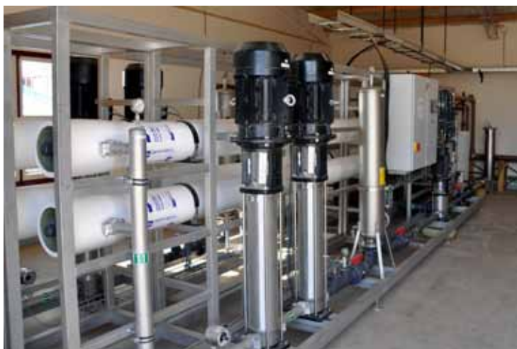
Fig. 5. I den varme Chaco foregår en evig jagt efter vand. I byen Filadelfia opsamler hver eneste husholdning det sparsomme regnvand. Vandet opbevares i tanke under jorden. Byen har over 20 vandreservoirer. Det højteknologiske anlæg på billedet er købt i Tyskland og filtrerer og udtrækker salt af saltholdigt grundvand, så det omdannes til rent drikkevand.
