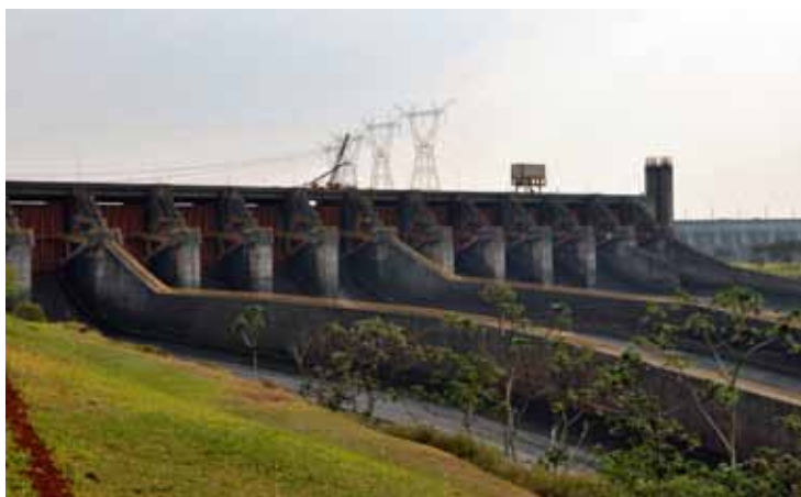
Fig. 7. Itaipú-dæmningen er på højde med et 65 etagers højhus. Til byggeriet er brugt knap 13 mio. m 3 cement. Det er 15 gange mere cement end der blev brugt til Eurotunnelen eller hvad der svarer til byggeriet af 210 store sportsarenaer. Kilde: Itaipú Binacional.
