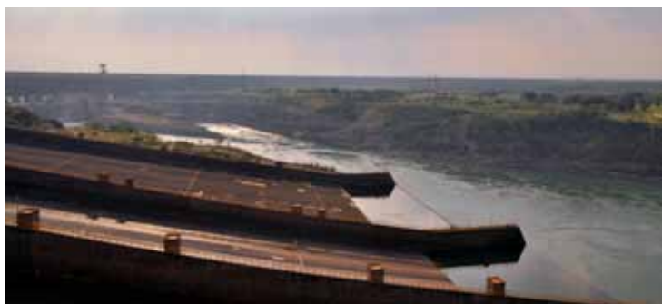
Fig. 8. Det opdæmmede vand fra Paraná-floden sendes gennem Itaipú-værkets enorme turbiner, som årligt producerer så meget energi, at det ville kunne dække Danmarks samlede strømforbrug i over to år.
