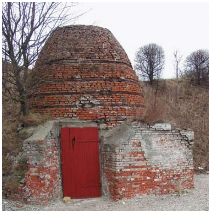
Ved Hoed kalkværk står denne smukke kubeovn fra 1930'erne.
