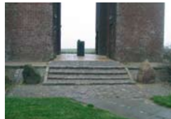
Figur 8: Ejer Bavnehøj fotograferet fra syd. Koten ved foden af trappen er 170,31 m DVR90, toppen af trappen er i ca. 170,90 m DVR90.
