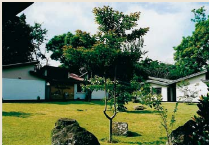
Mellemfolkeligt Samvirkes kursuscenter består blandt andet af mange mindre huse til kursister samt en stor undervisningsafdeling.
