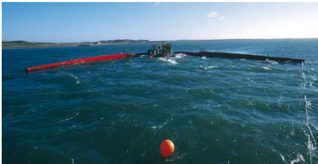
Figur 3: Wave Dragon er et offshore bølgeenergianlæg. Bølgerne koncentrerer mellem reflektorerne og skyller indover den centrale rampe. På billedet ses prototypen fra forsøgene i Nissum Bredning (Limfjorden). Den hvide container indeholder måleudstyr mv. fra Aalborg Universitet og vil ikke være på det kommende demonstrationsanlæg.
