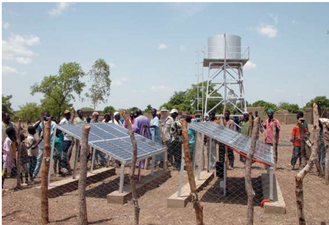
Med 16 stk. 60 Watts solpaneler er det muligt at dække vandforsyningen i en landsby med 1000 indbyggere. Foto: Tom Burell.
