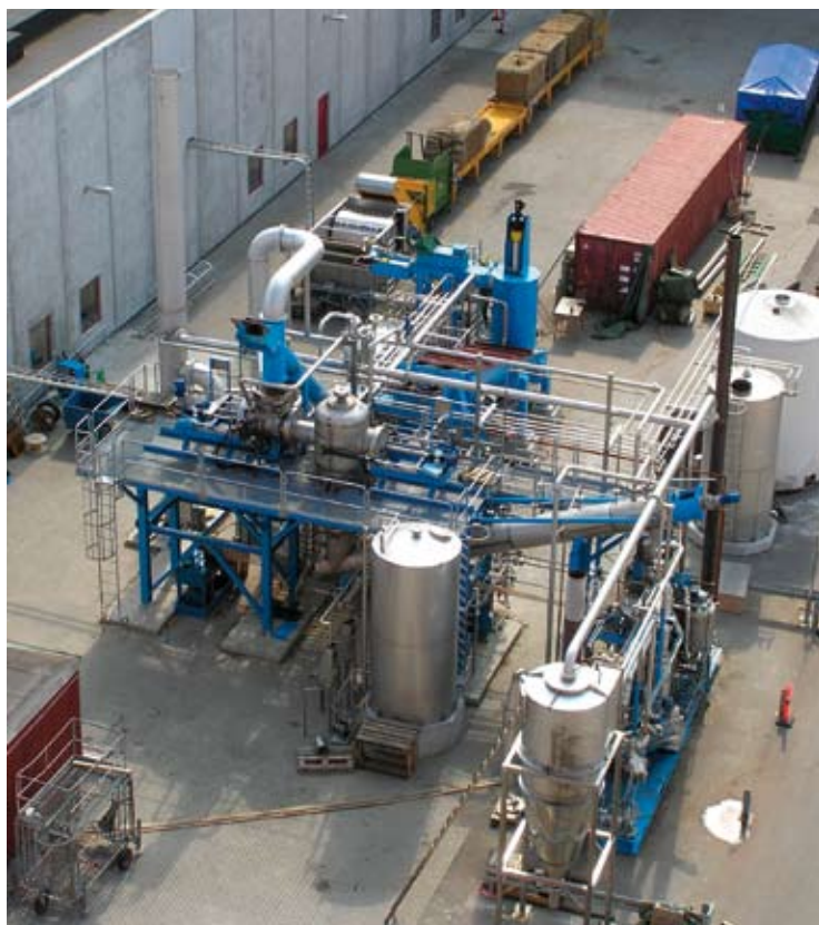
Figur 2: IBUS-anlægget under opførelse på Fynsværket i Odense i august 2005. Foto Elsam.
