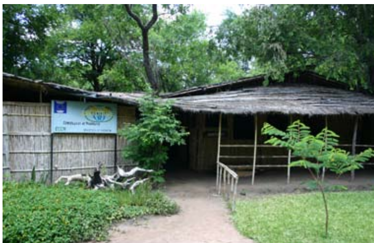
Ingen træer er gået til for at bygge Envirotrades kontor. Alt er af bambus, siv og palmeblade.
